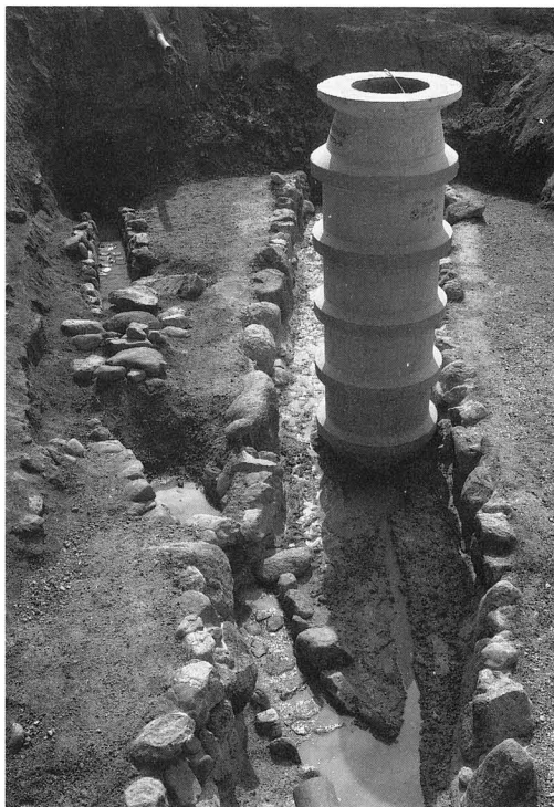
2. SX10・SD20復原工事竣工 (北から)
